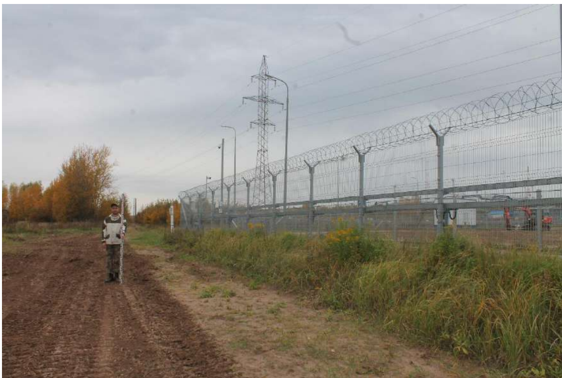
Илл.12. Объект «Камера пуска СОД Горький-Ярославль, 0 км. Реконструкция» в Кстовском районе Нижегородской области. Точка фотофиксации №2. Вид с СВ.
