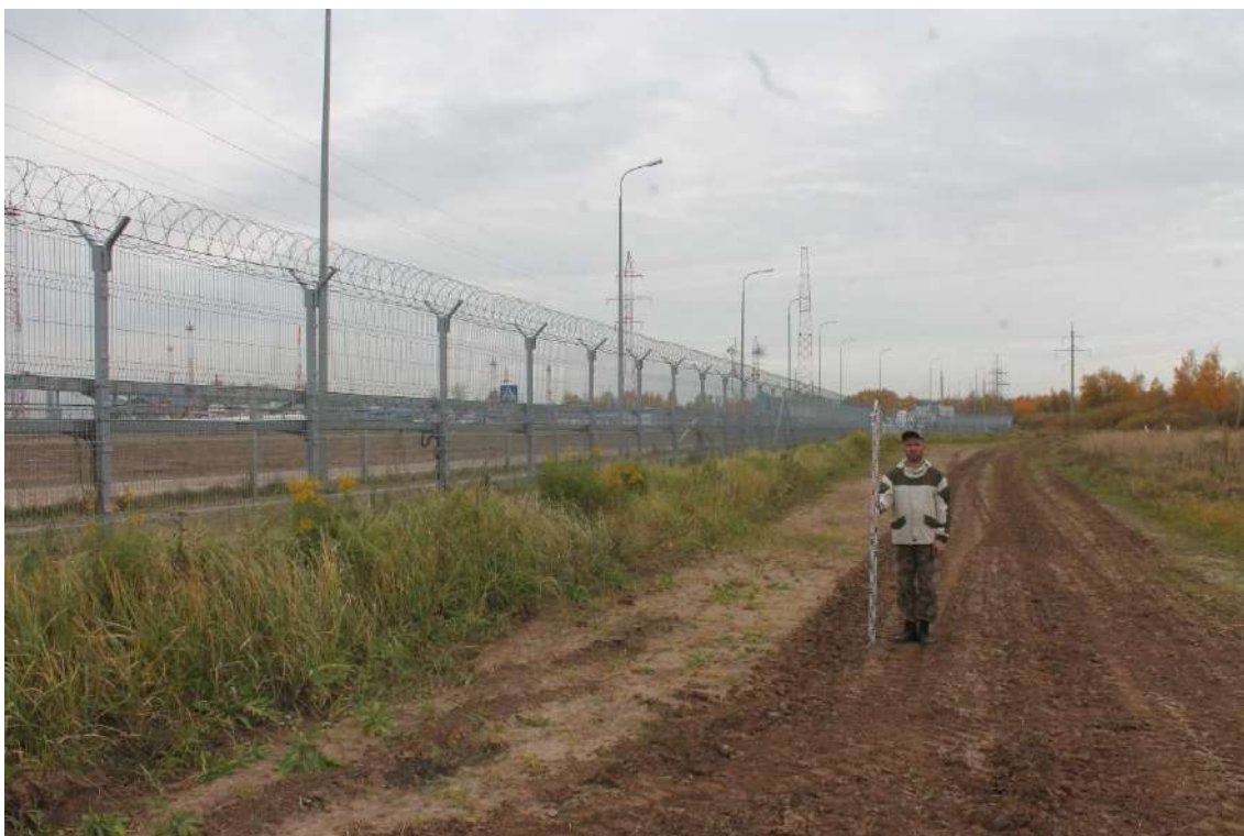
Илл.10. Объект «Камера пуска СОД Горький-Ярославль, 0 км. Реконструкция» в Кстовском районе Нижегородской области. Точка фотофиксации №2. Вид с ЮЗ.
