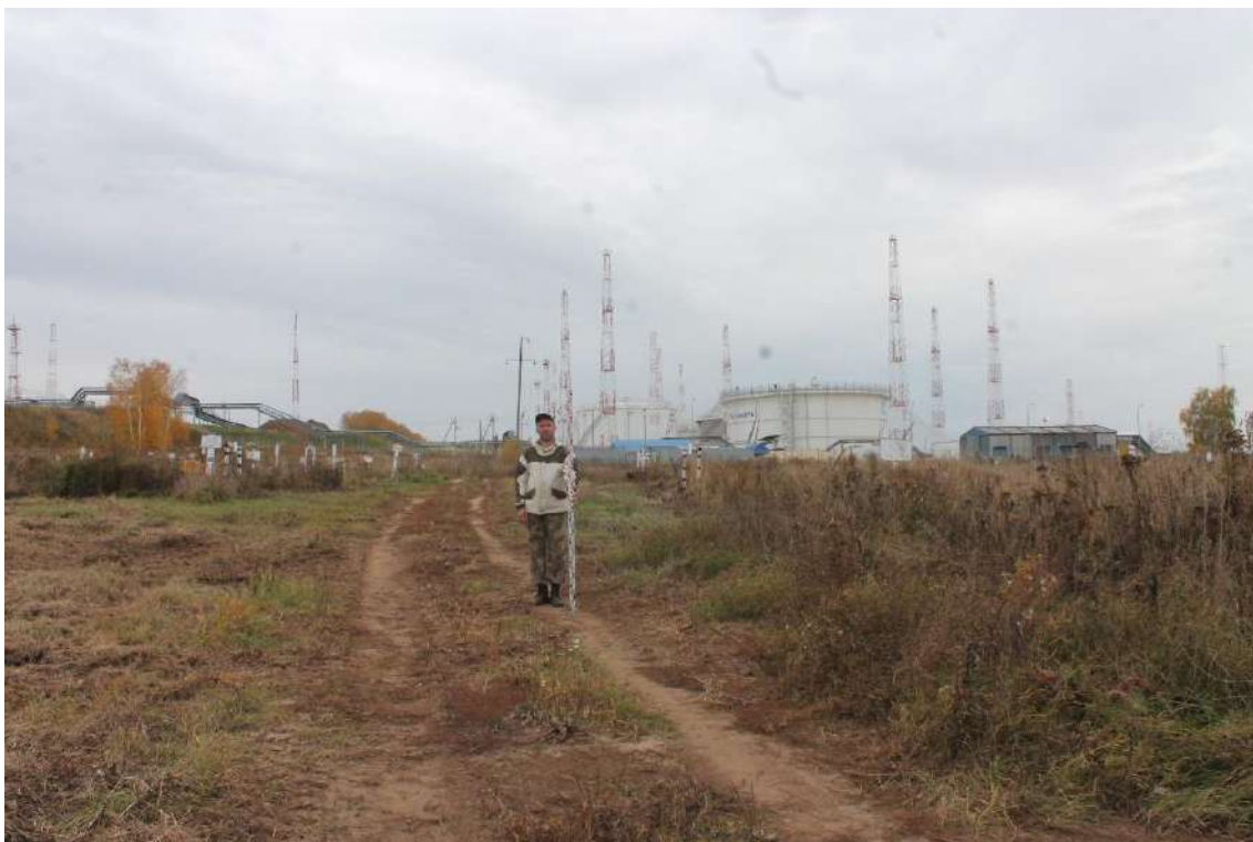
Илл.6. Объект «Камера пуска СОД Горький-Ярославль, 0 км. Реконструкция» в Кстовском районе Нижегородской области. Точка фотофиксации №1. Вид с востока.
